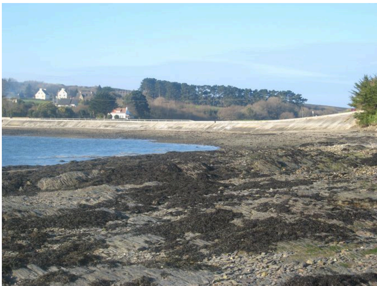
Digue-route de Kervian
