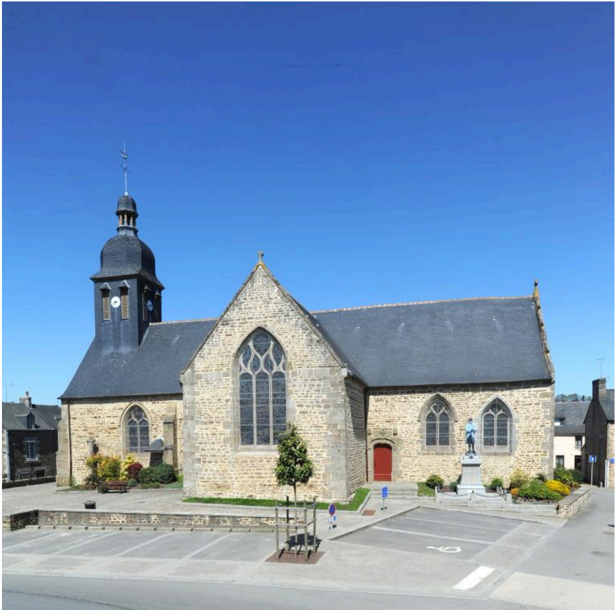
Vue générale : côté Sud
