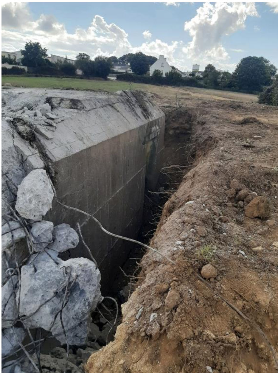
Vue de la déconstruction (25 septembre 2022)
