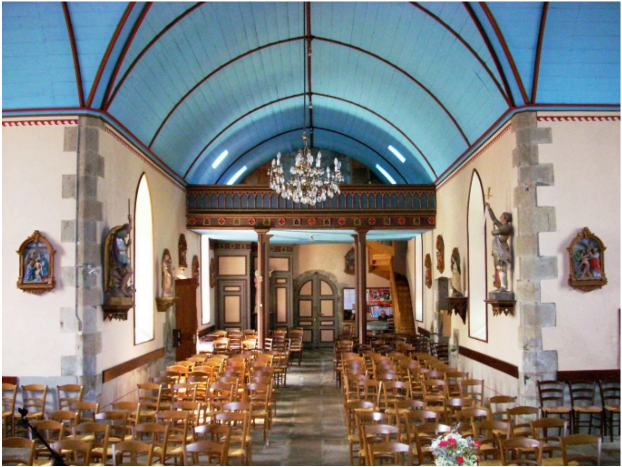
Tréglonou, église paroissiale : vue axiale ouest
