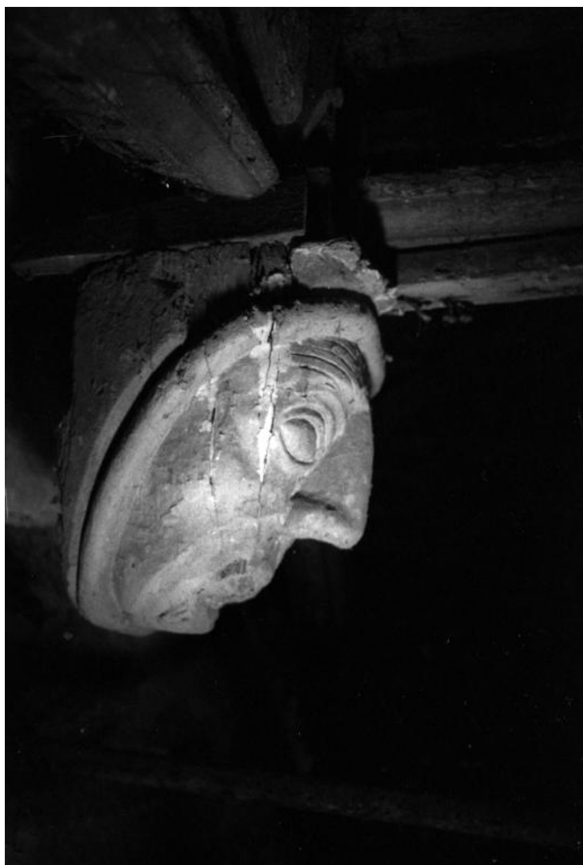
Charpente, détail de la clé 31.
