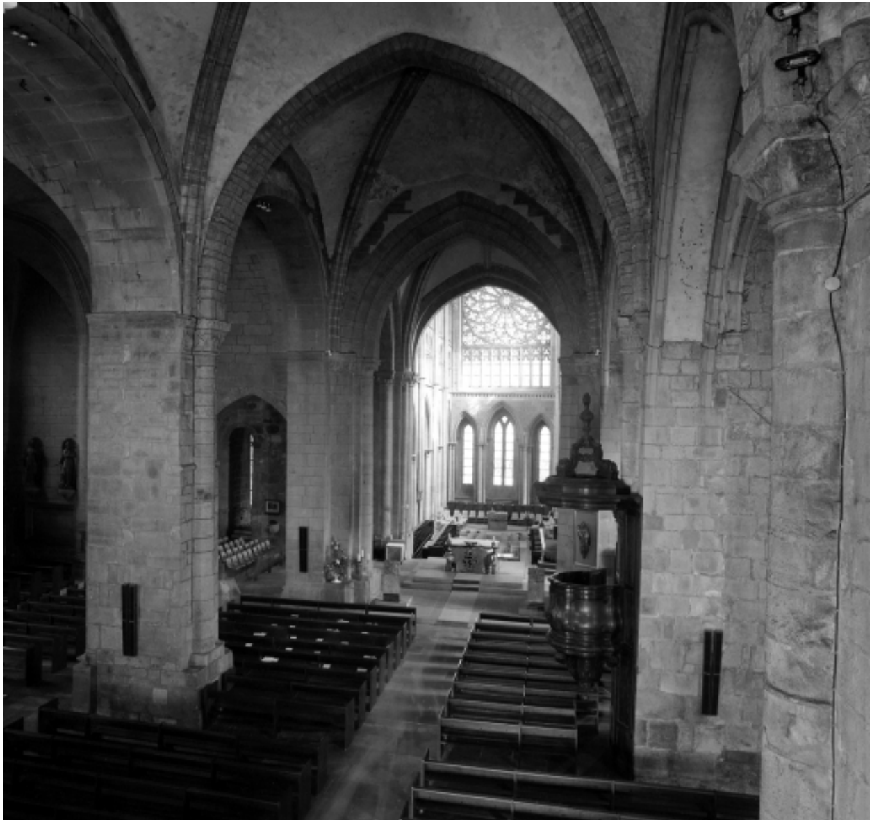
Intérieur : vue générale vers le chœur
