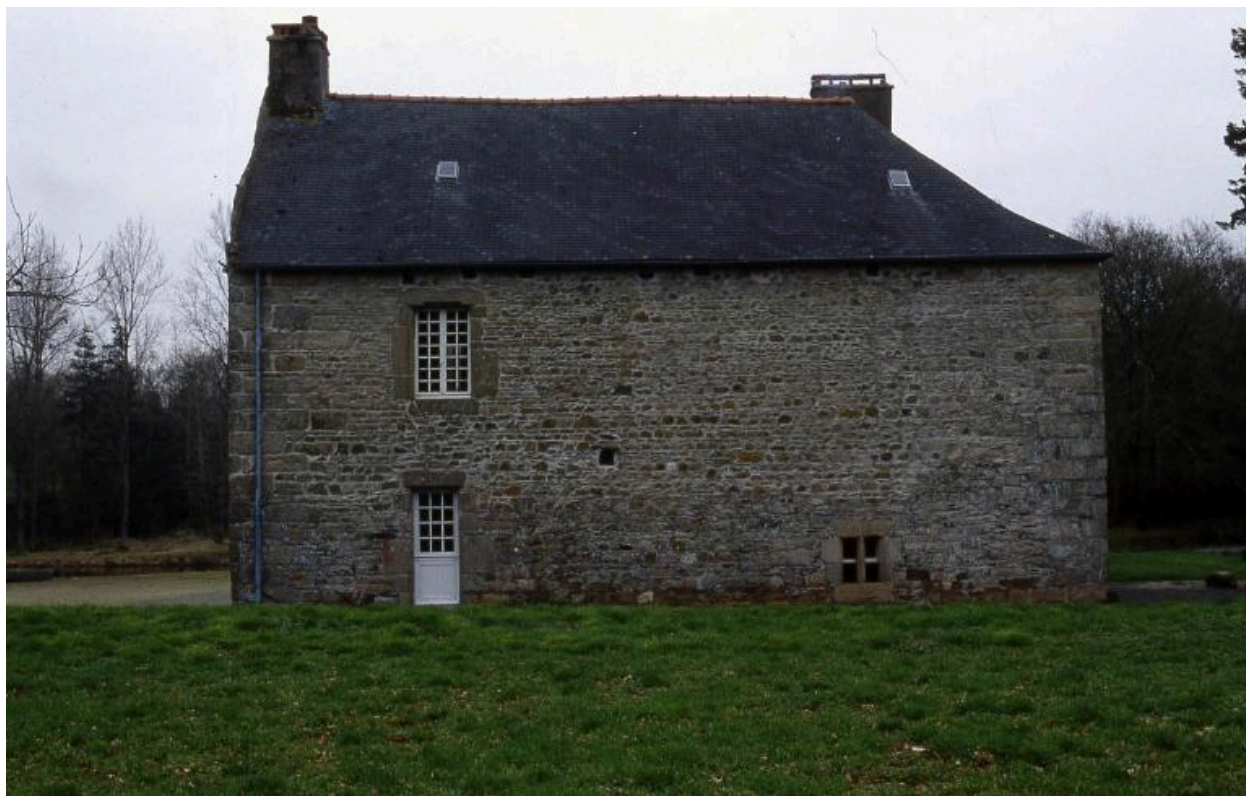
Logis : vue générale prise du sud-est.
