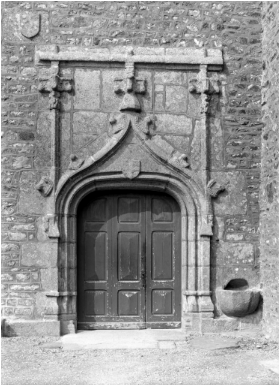
Elévation Sud, porte : vue générale
