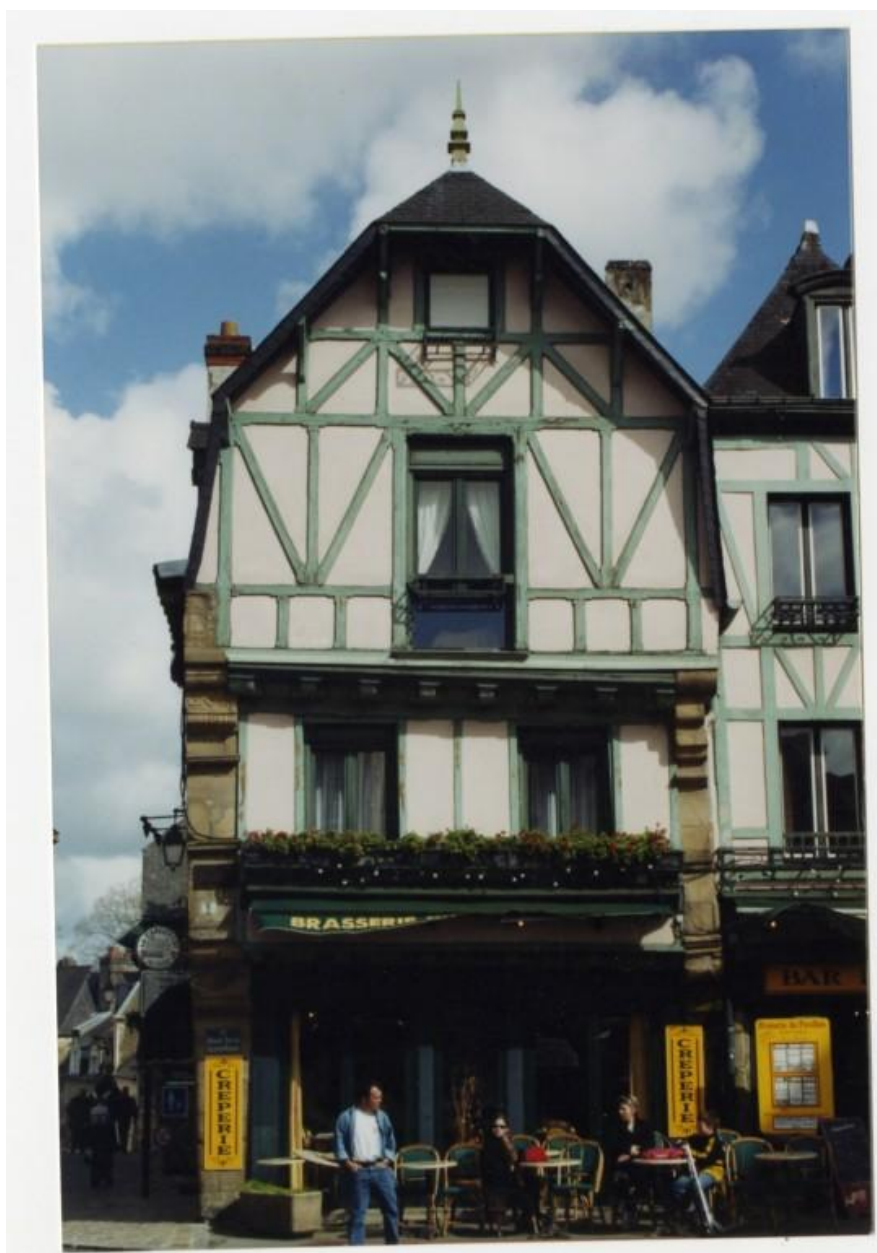
Détail de la façade au début des années 2000.
