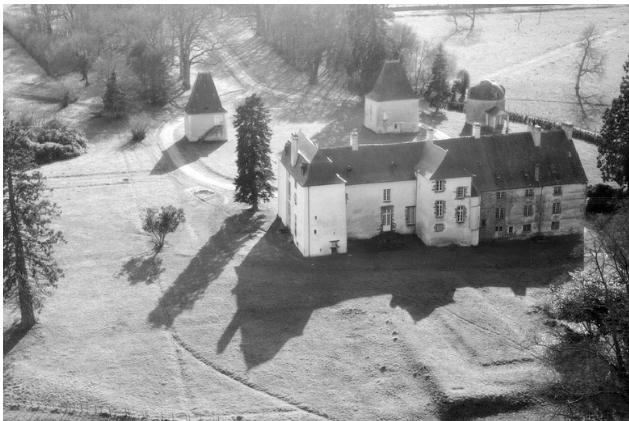
Vue aérienne, nord.
