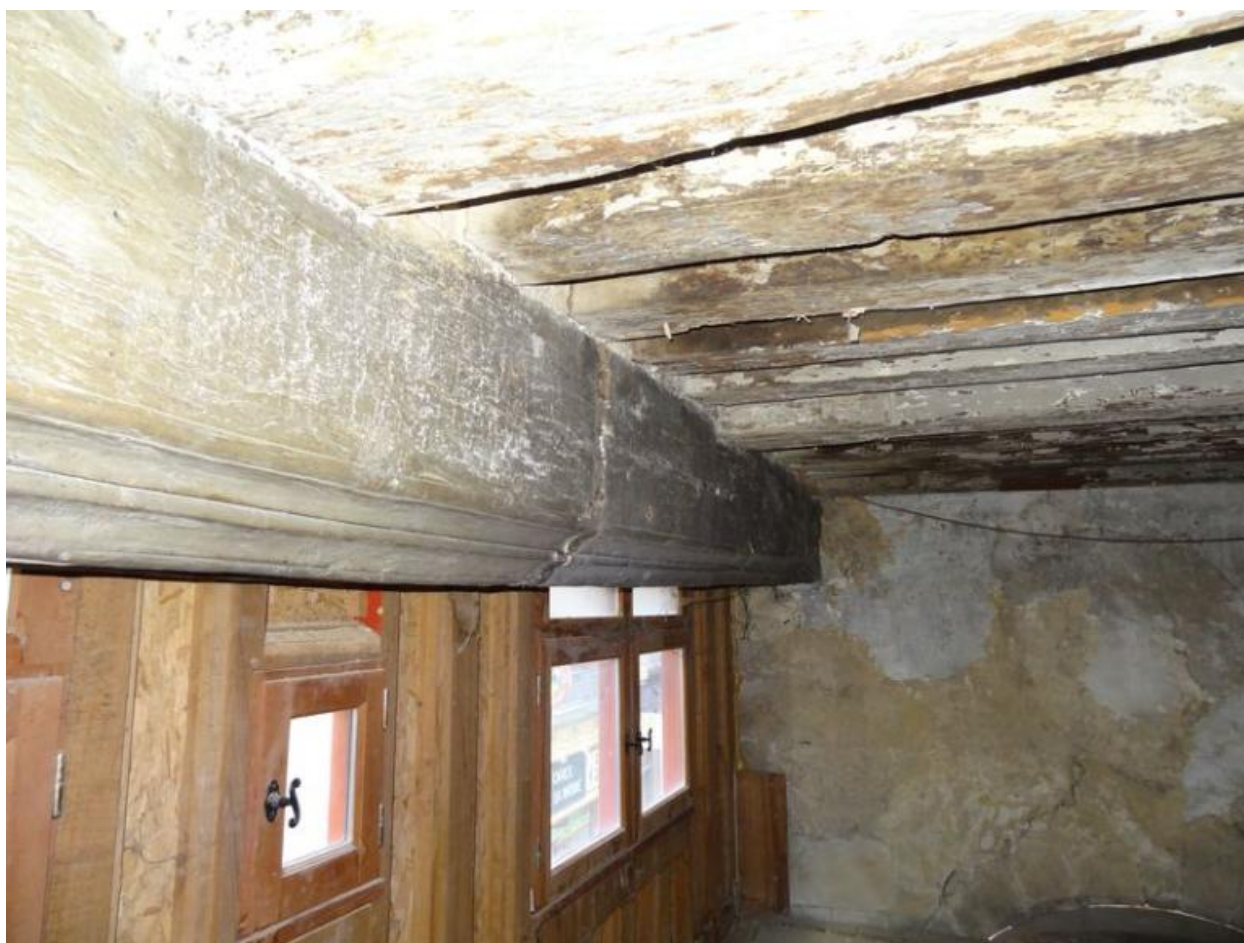
Détail du mur sud de l'entresol
