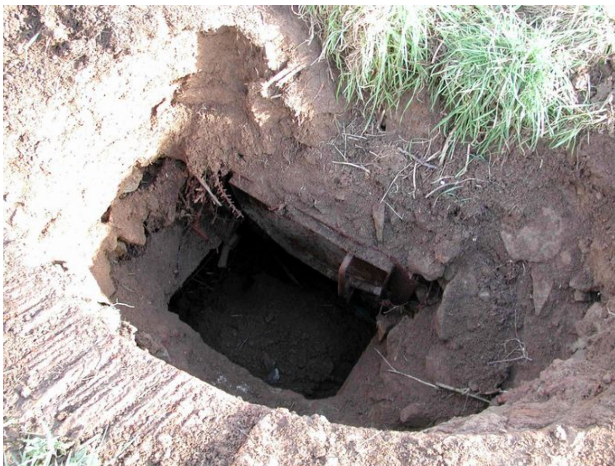
Vue du bunker - casemate de type 634 de Kerriou à Saint-Anne du Portzic (B 97 / 15) : cloche blindée découpée par les ferrailleurs dans les années 1960, état en 2003
