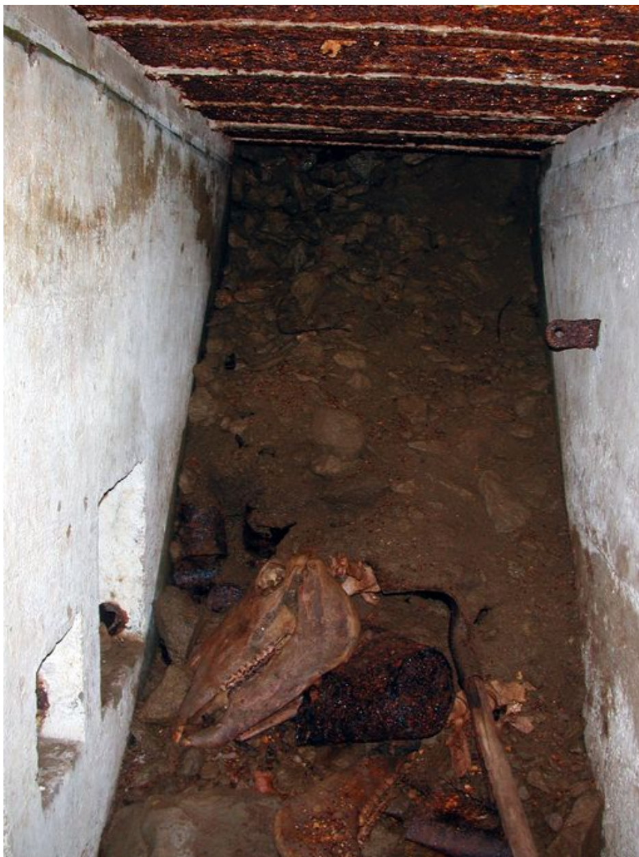
Vue de l'entrée principale remblayée (état en 2003)
