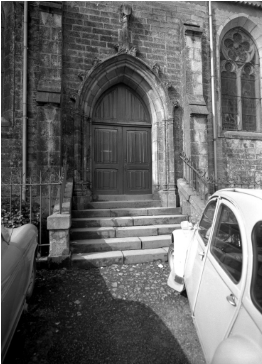
Châteaulin, église paroissiale Saint-Idunet : façade nord, porte, état en 1972
