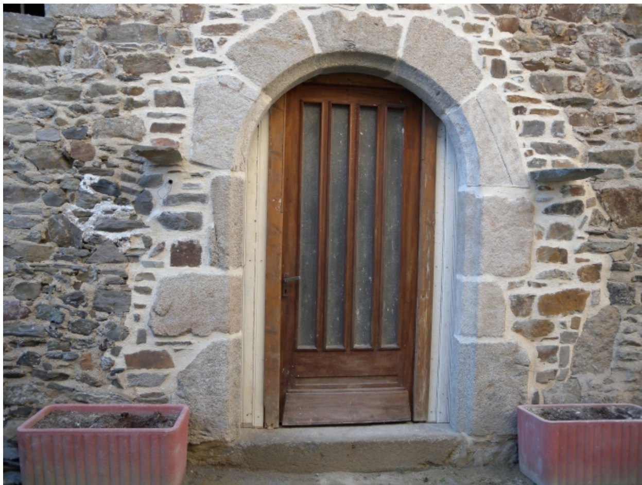
Vue de détail d'une ouverture en plein cintre, rue des Frères Durand
