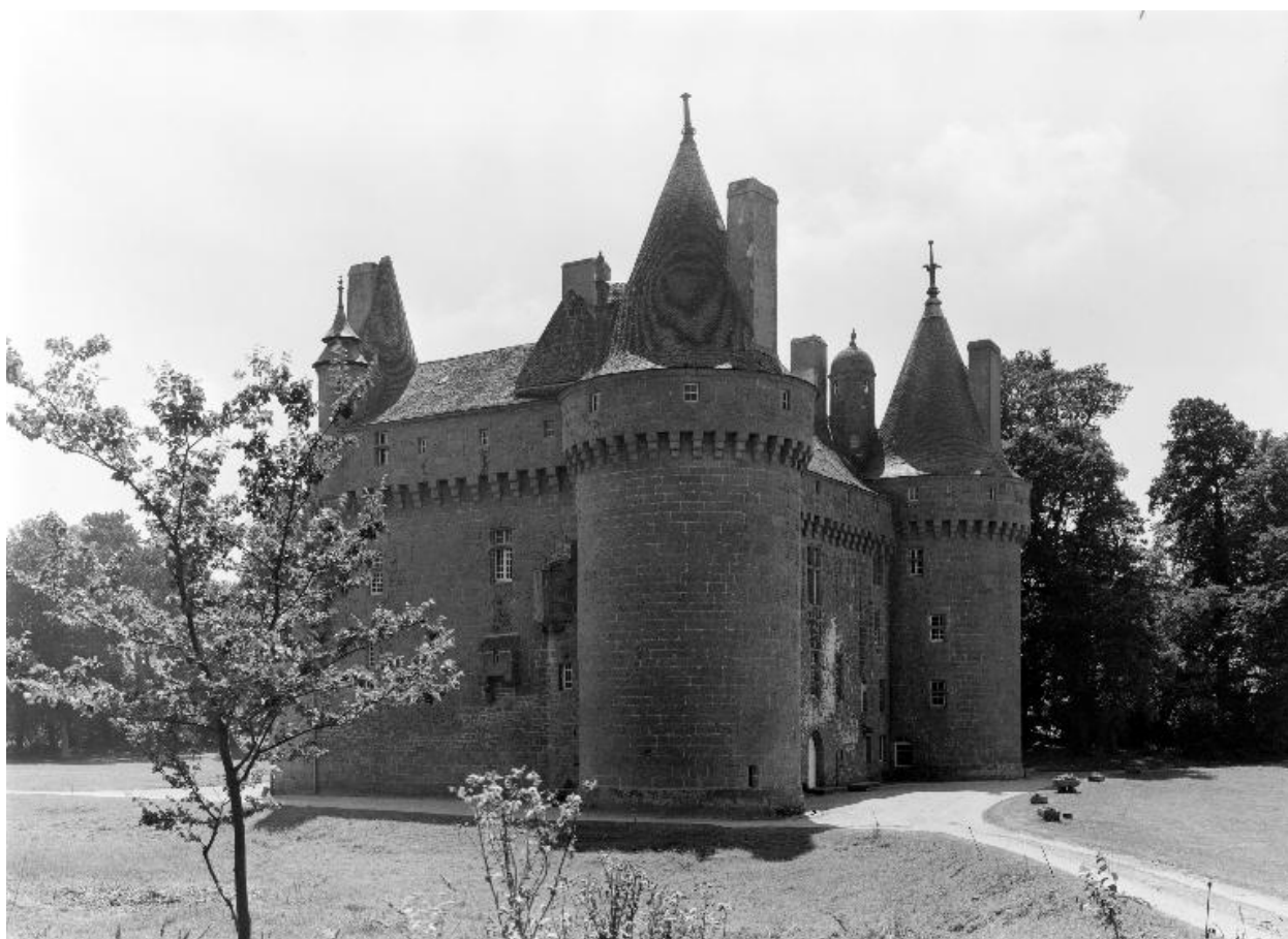
Façade nord-est, vue générale
