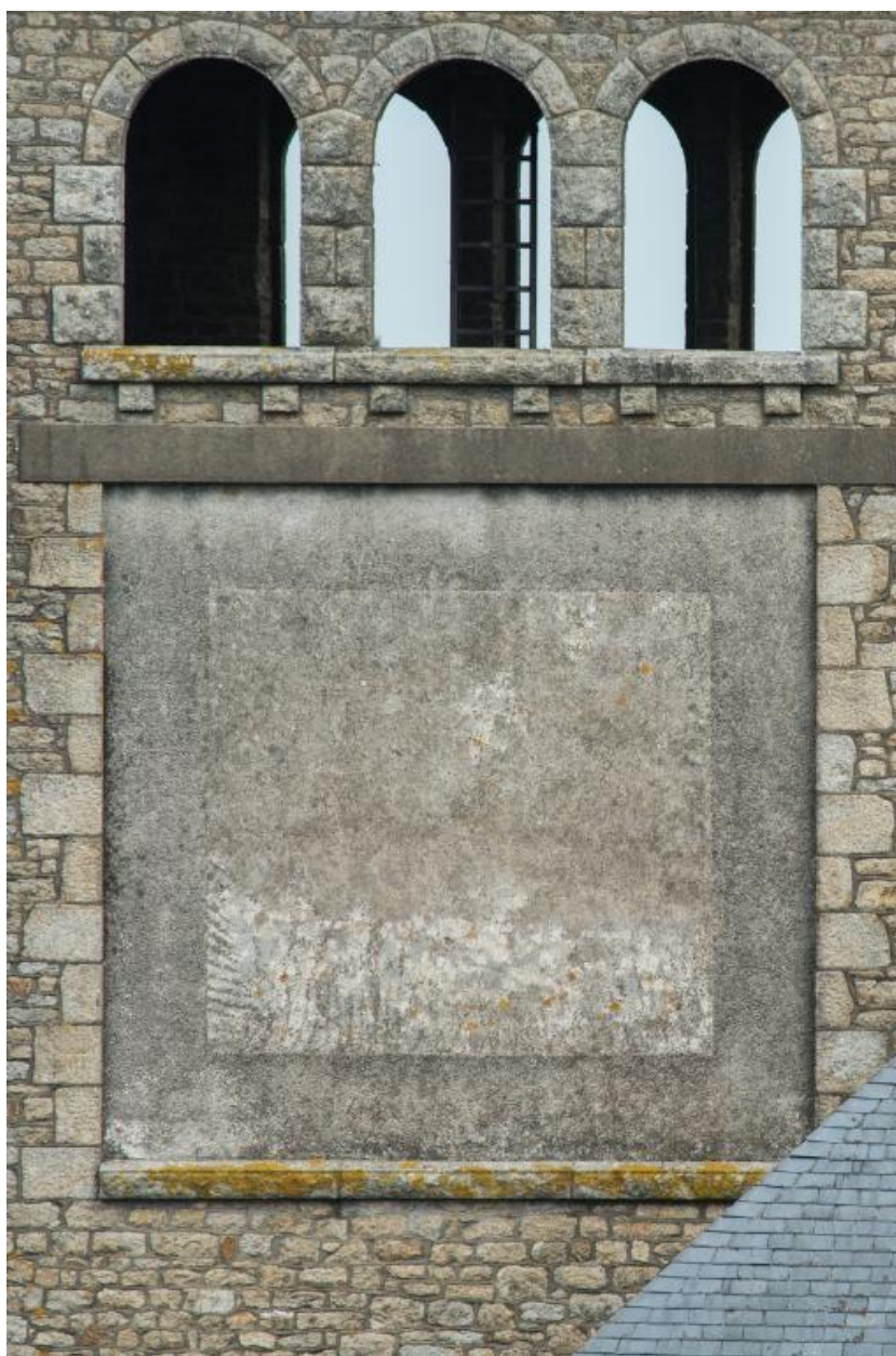
Vue de détail du campanile, prise du sud (depuis un étage de l'externat de 1961). Georges-Robert Lefort, architecte, 1929.
