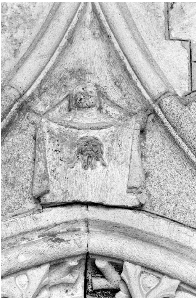
Porche : porte d'accès à l'église, détail de l'accolade : relief (ange présentant la sainte Face)
