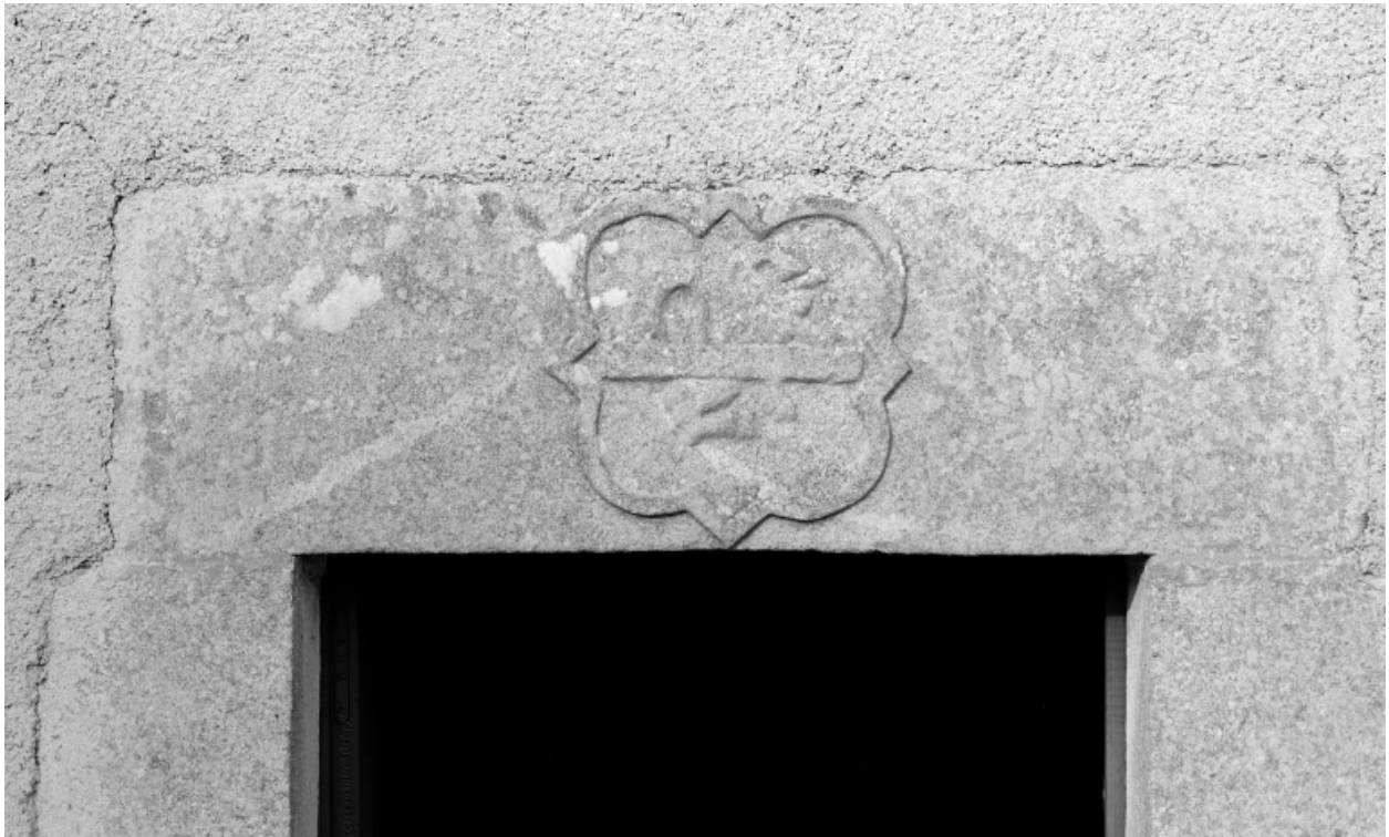
Elévation Sud, baies : détail du linteau aux armes des Henry
