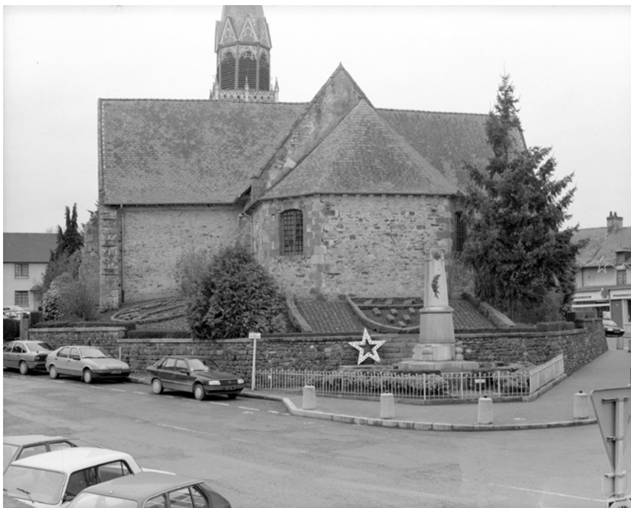
Vue partielle est
