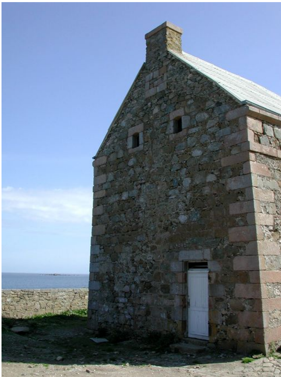
Vue du pignon ouest (état en 2006)
