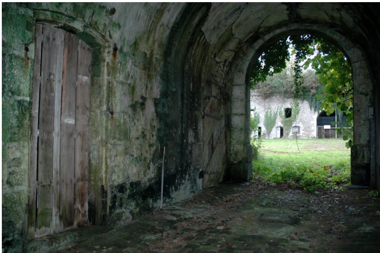
Vue du fort de Penfeld : le passage d'entrée, baie de la poudrière
