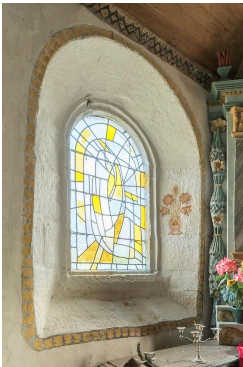
Vue de la baie nord du choeur
