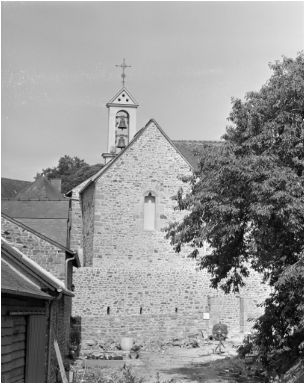
Elévation Est, pignon Est : vue générale
