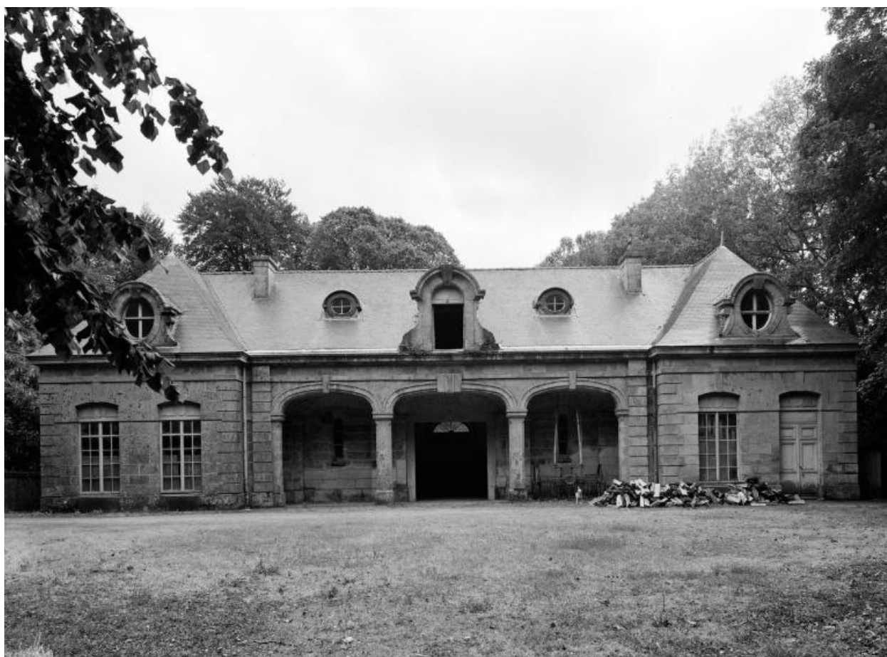
Ecuries, élévation Nord, vue générale
