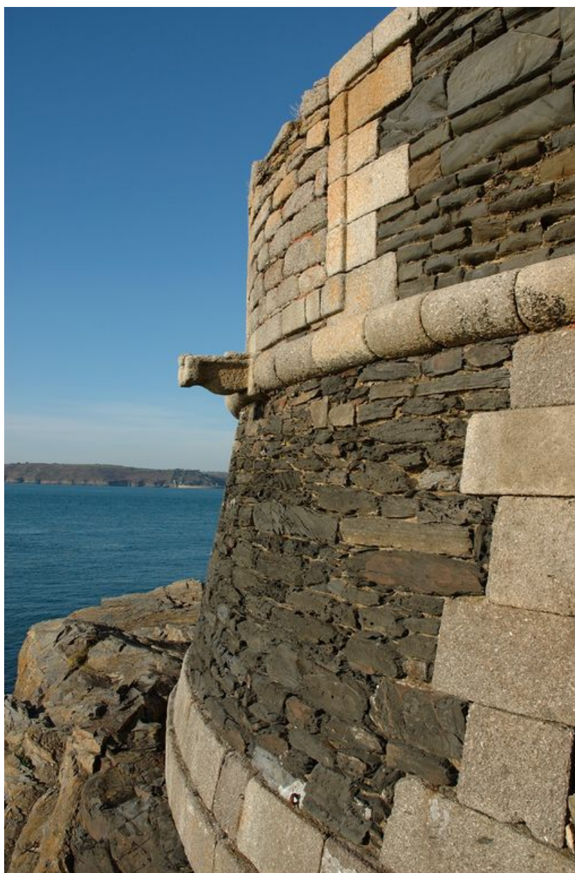
Vue de la batterie de Cornouaille : détail de l'escarpe (mur de soutènement de la batterie). Encadrement des créneaux, et cordon en granite ; remplissage en moellons de schiste
