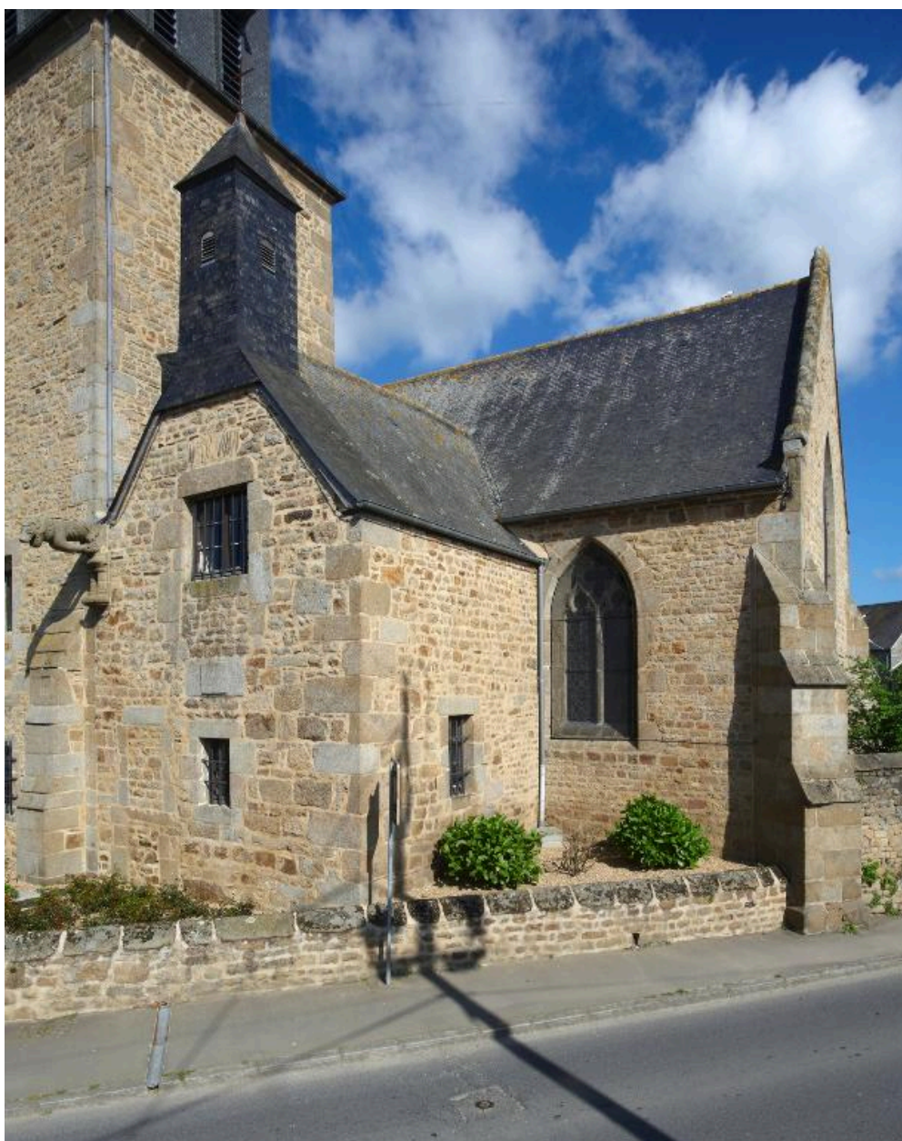
Sacristie et chevet (côté sud-est)
