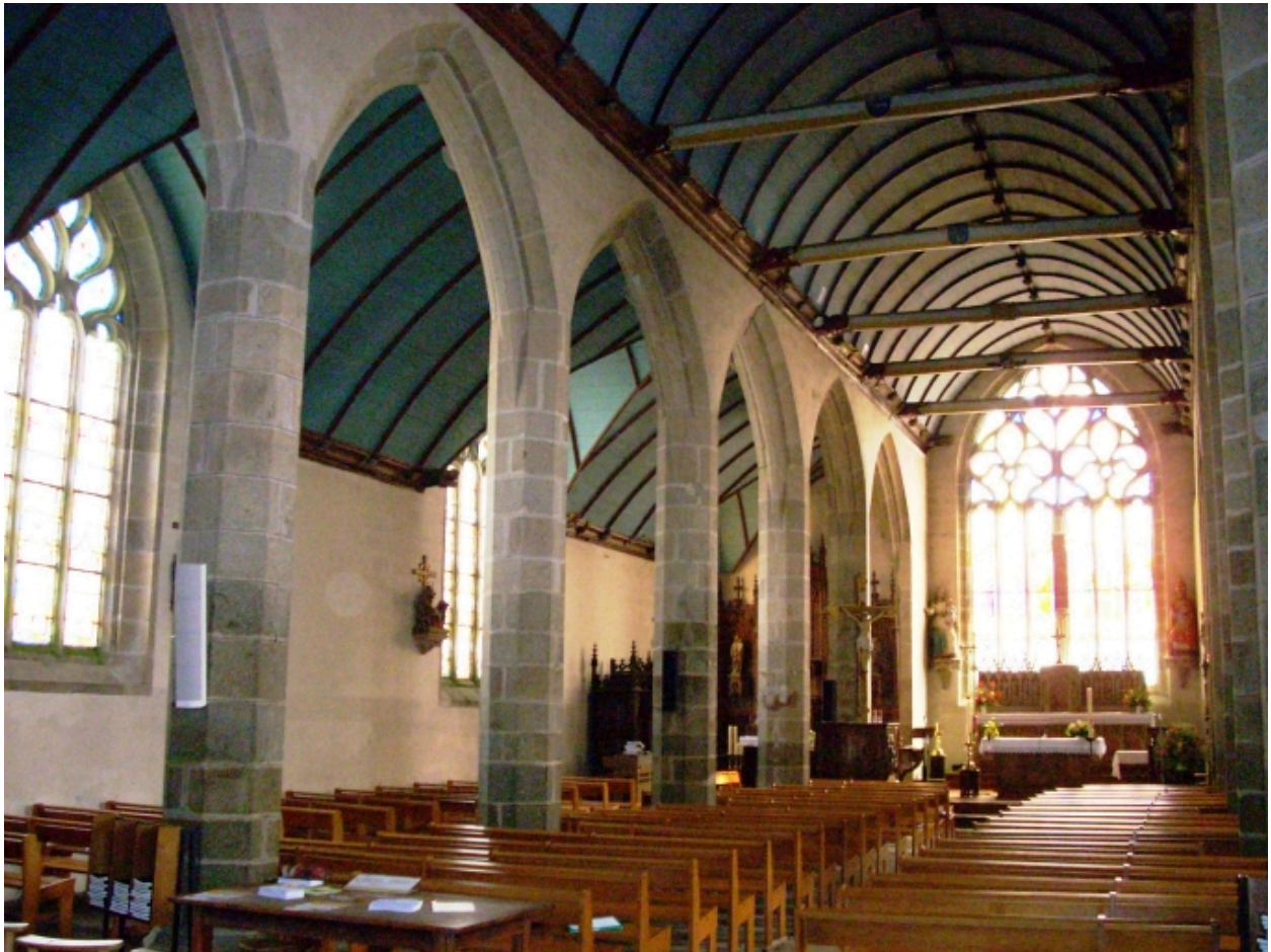
Plonévez-du-Faou, église paroissiale Saint-Pierre : vue transversale nord-est
