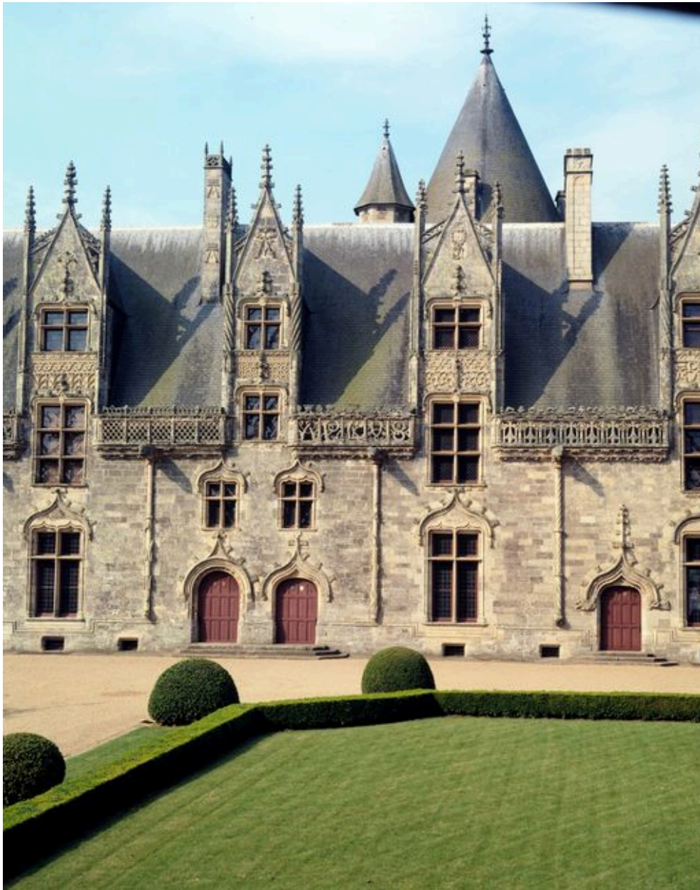
Logis, élévation sur cour : entrée principale et travée de l'escalier principal
