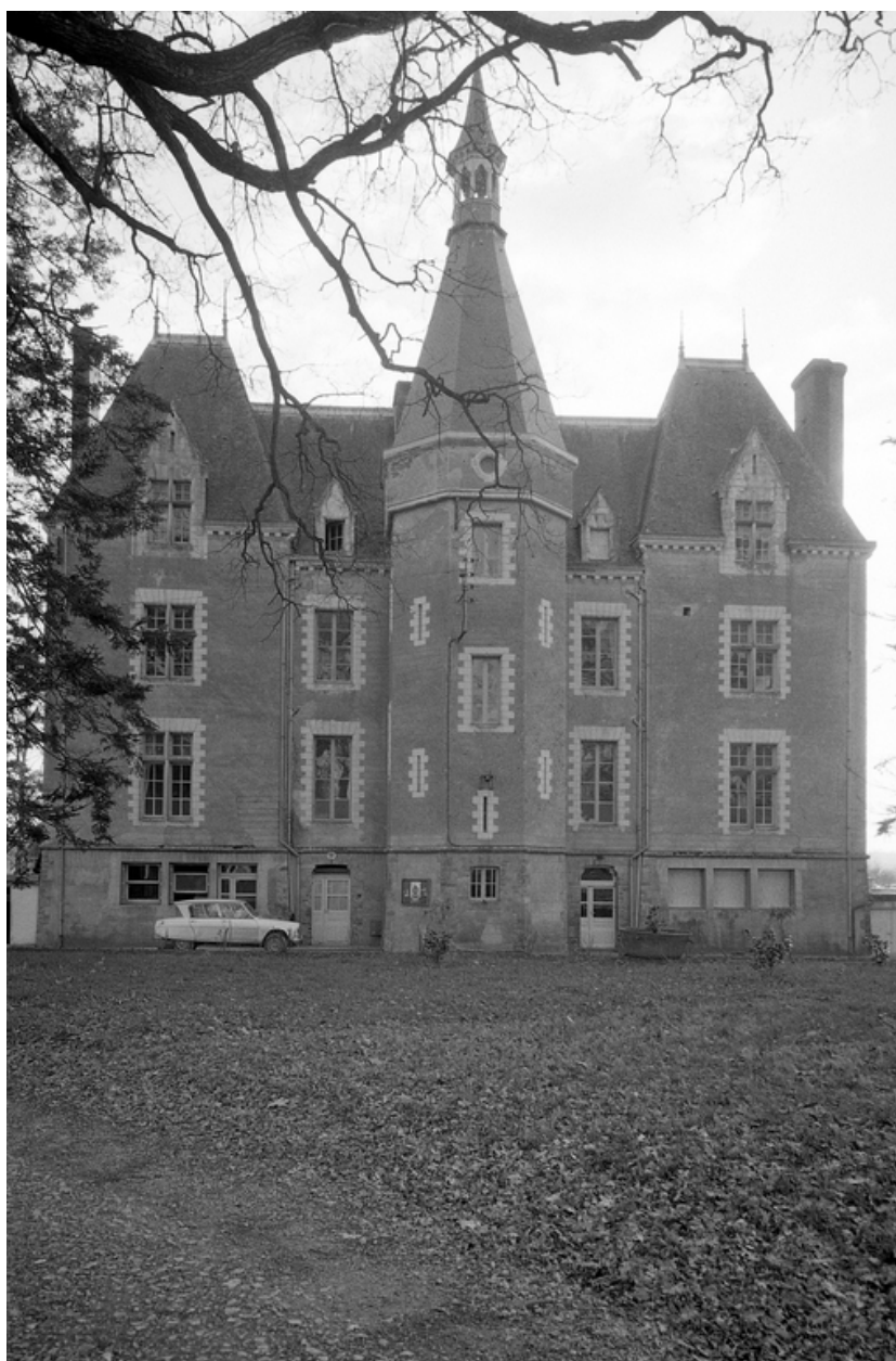
Vue générale, façade postérieure.
