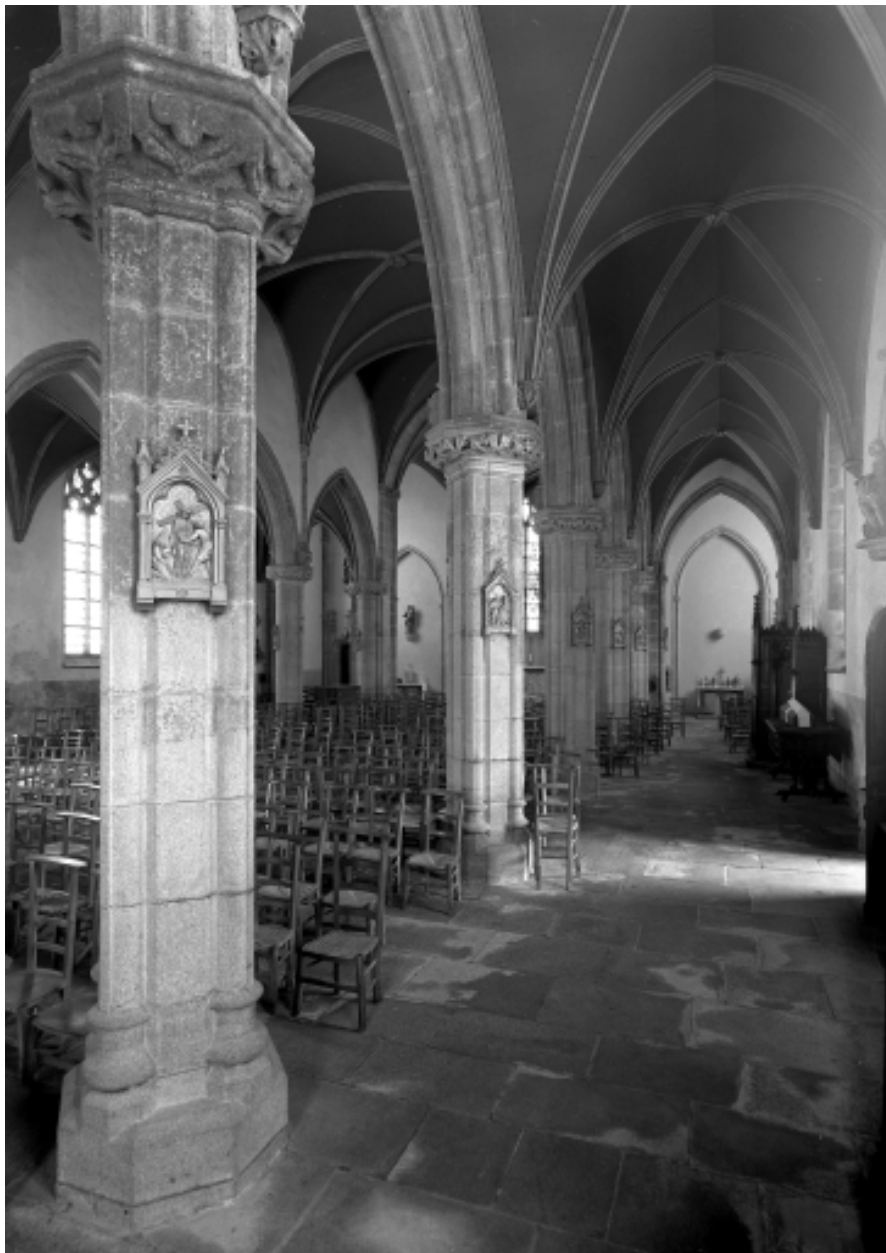
Plonévez-Porzay, église paroissiale Saint-Miliau : bas-côté sud, vers l'est, état en 1970
