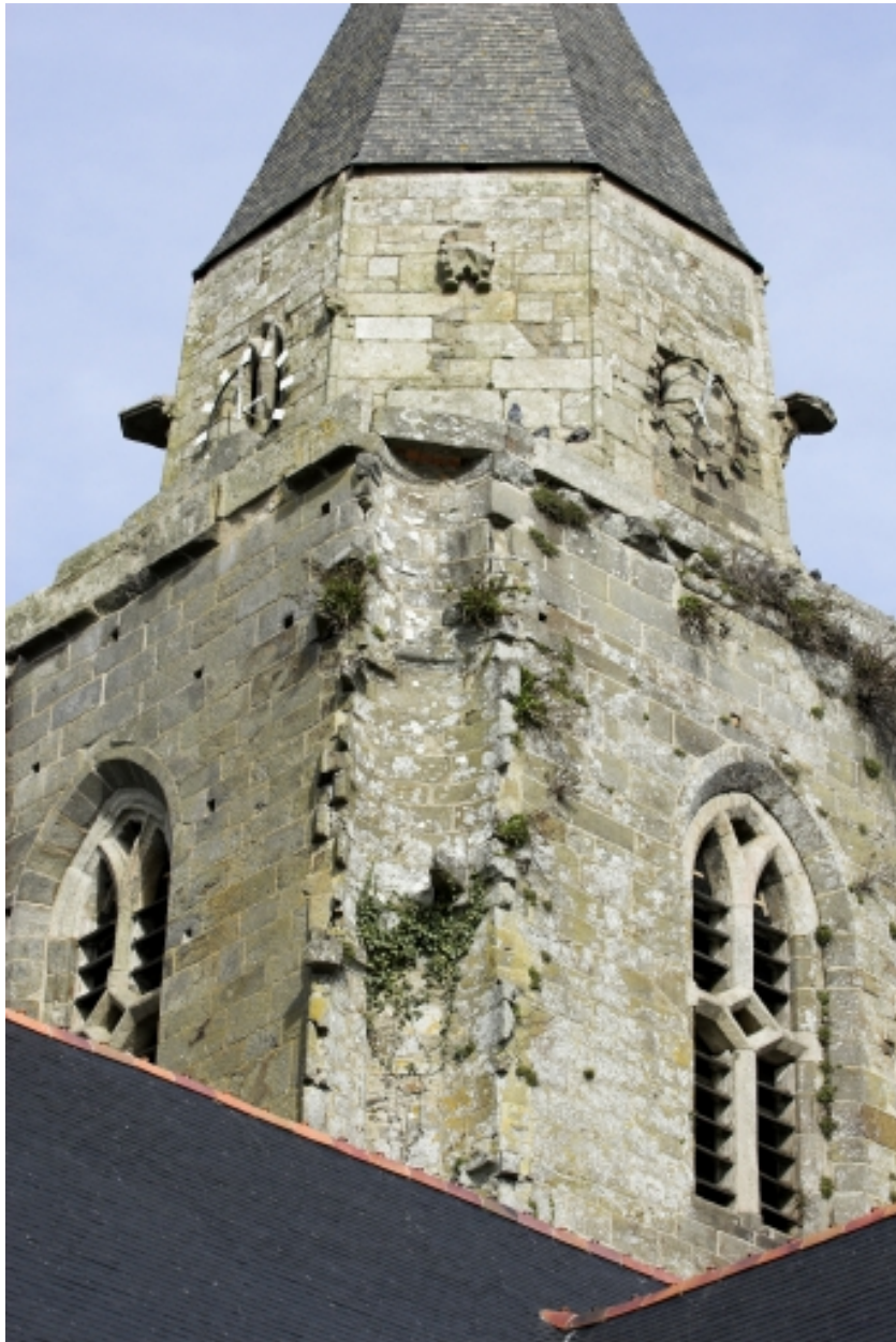
Tour-clocher, détail, arrachements
