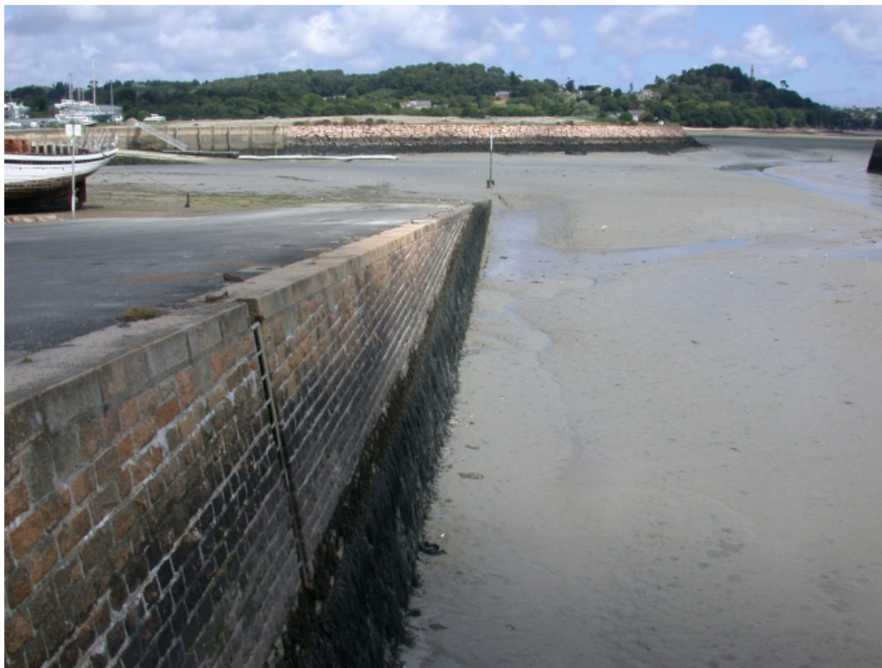
Vue du mur de quai en moellons de granite
