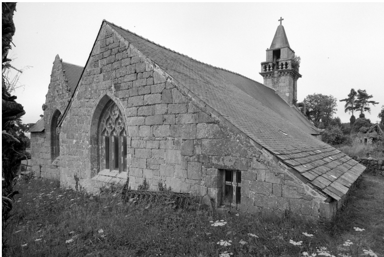
Chevet, élévation est : vue prise du nord est
