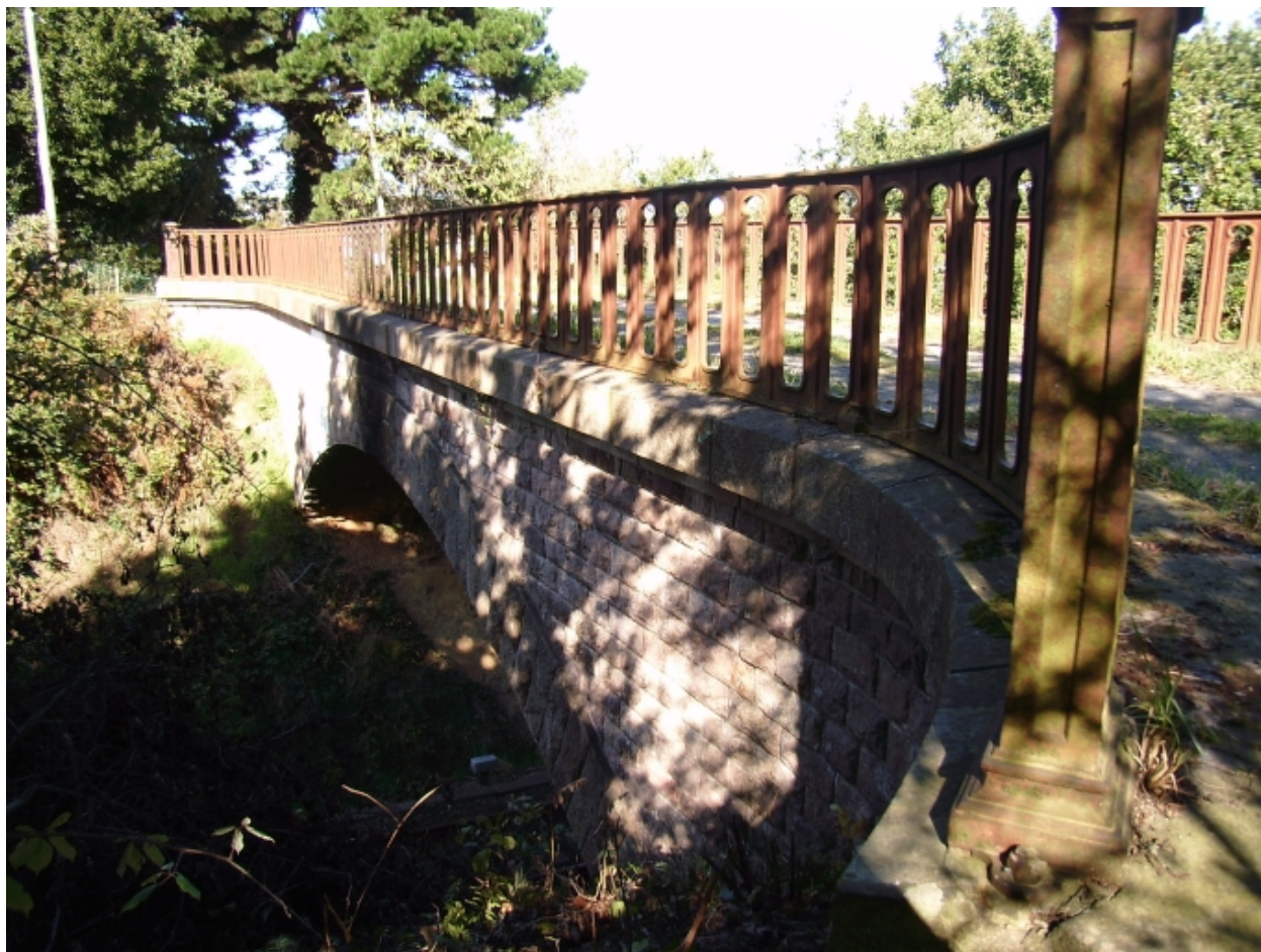
Vue générale du pont enjambant la voie ferrée à hauteur du lieu-dit Lostang
