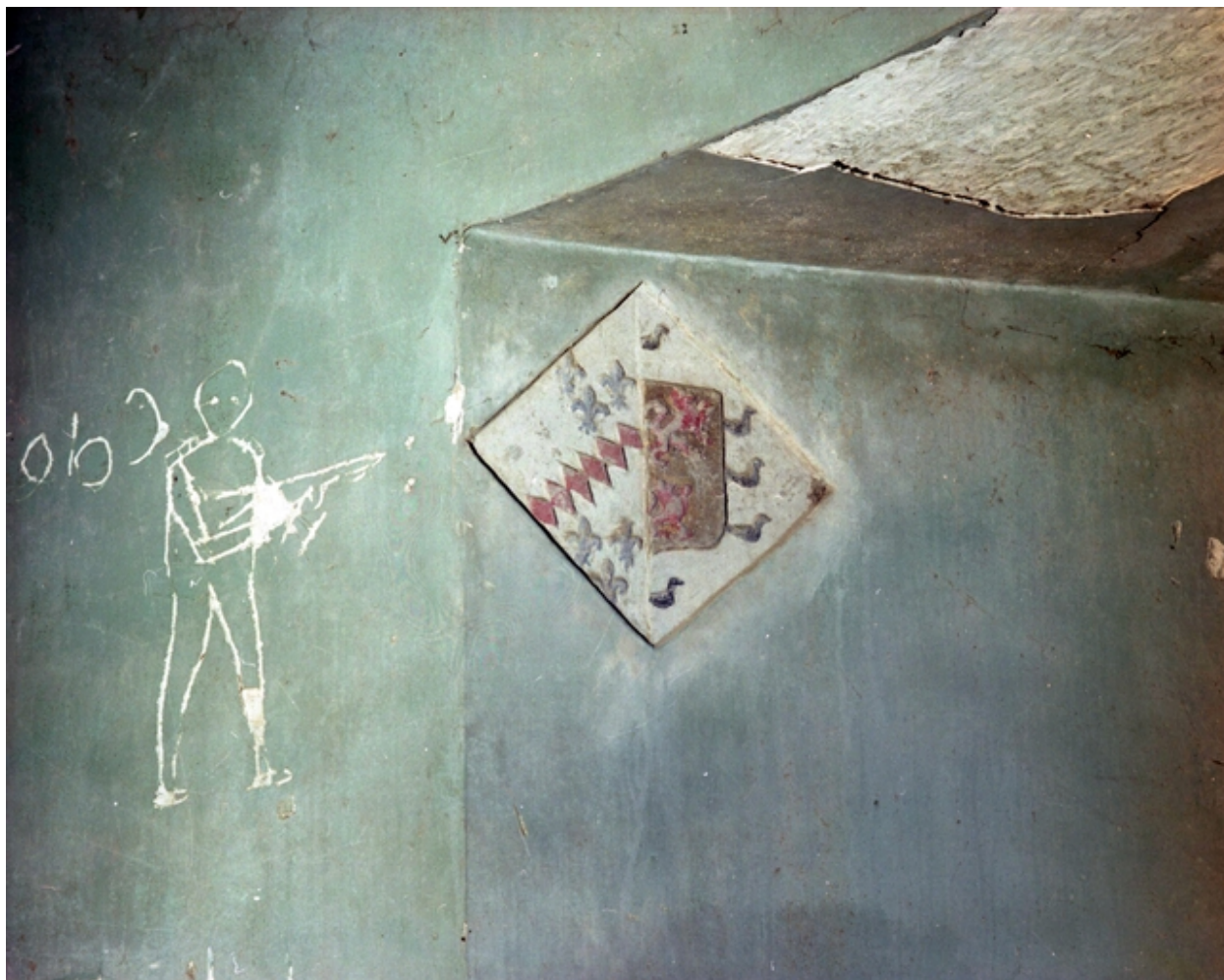
Escalier, écu, ébrasement de la fenêtre entre rez-de-chaussée et étage.
