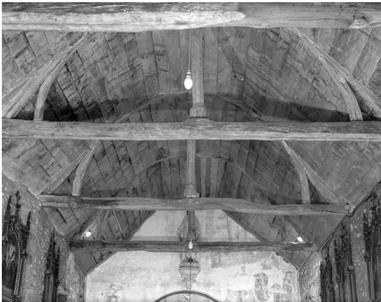
Vue générale de la charpente.
