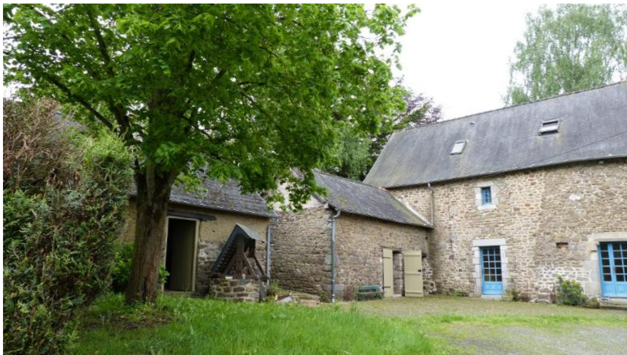
Vue générale nord
