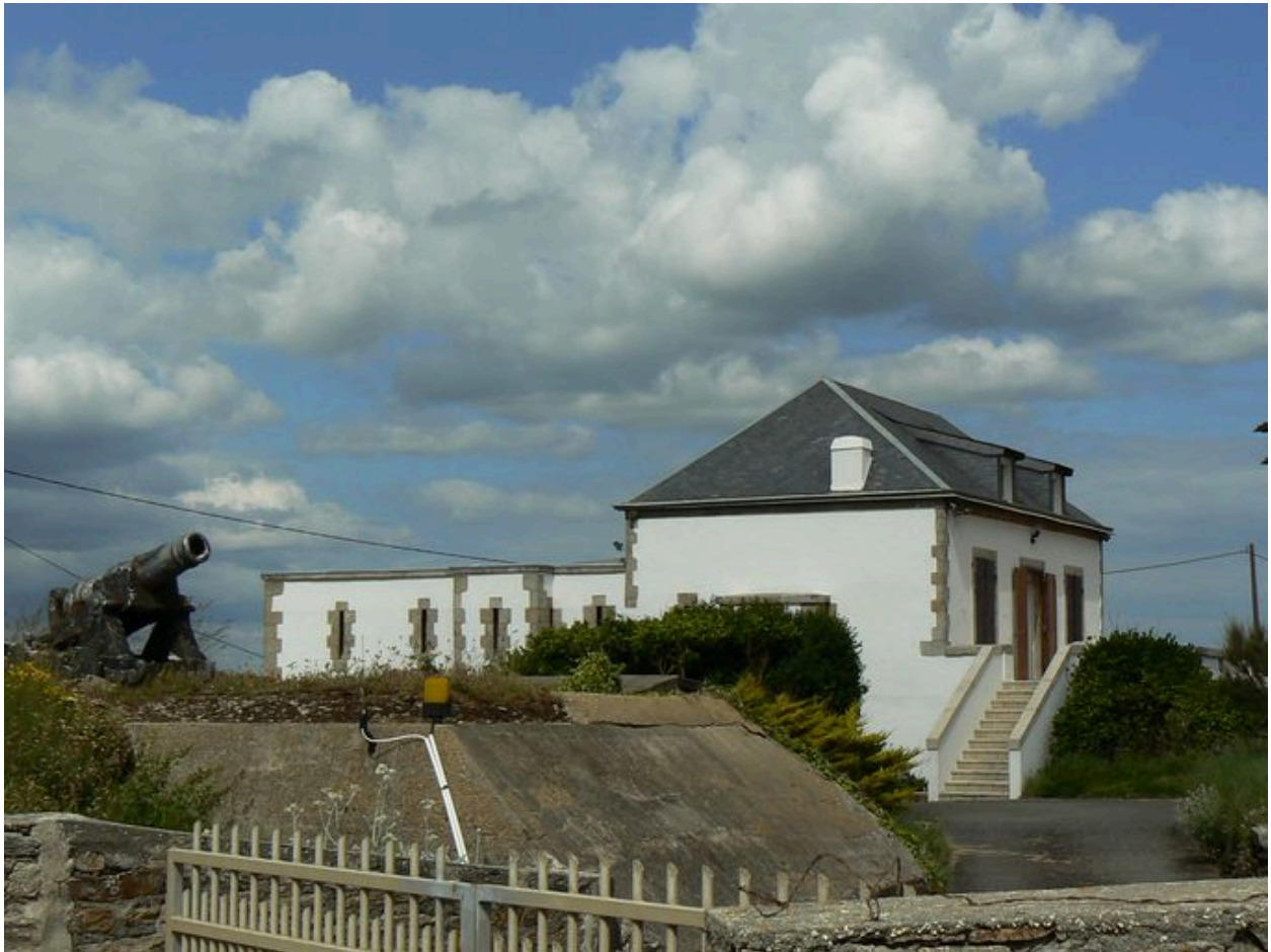
Vue générale du fort du Pouldu
