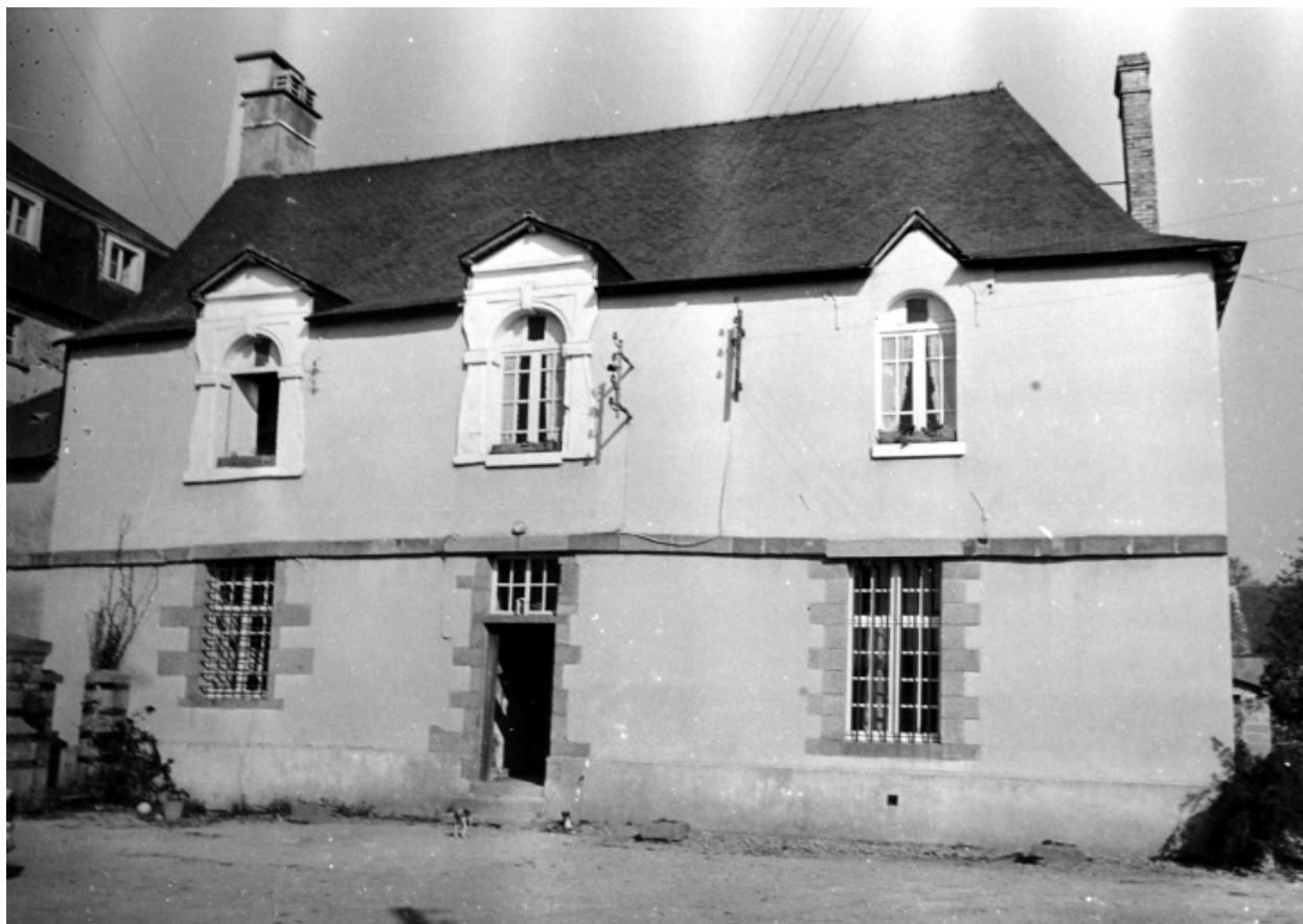
Métairie sud : le logis, façade antérieure (état en 1973)
