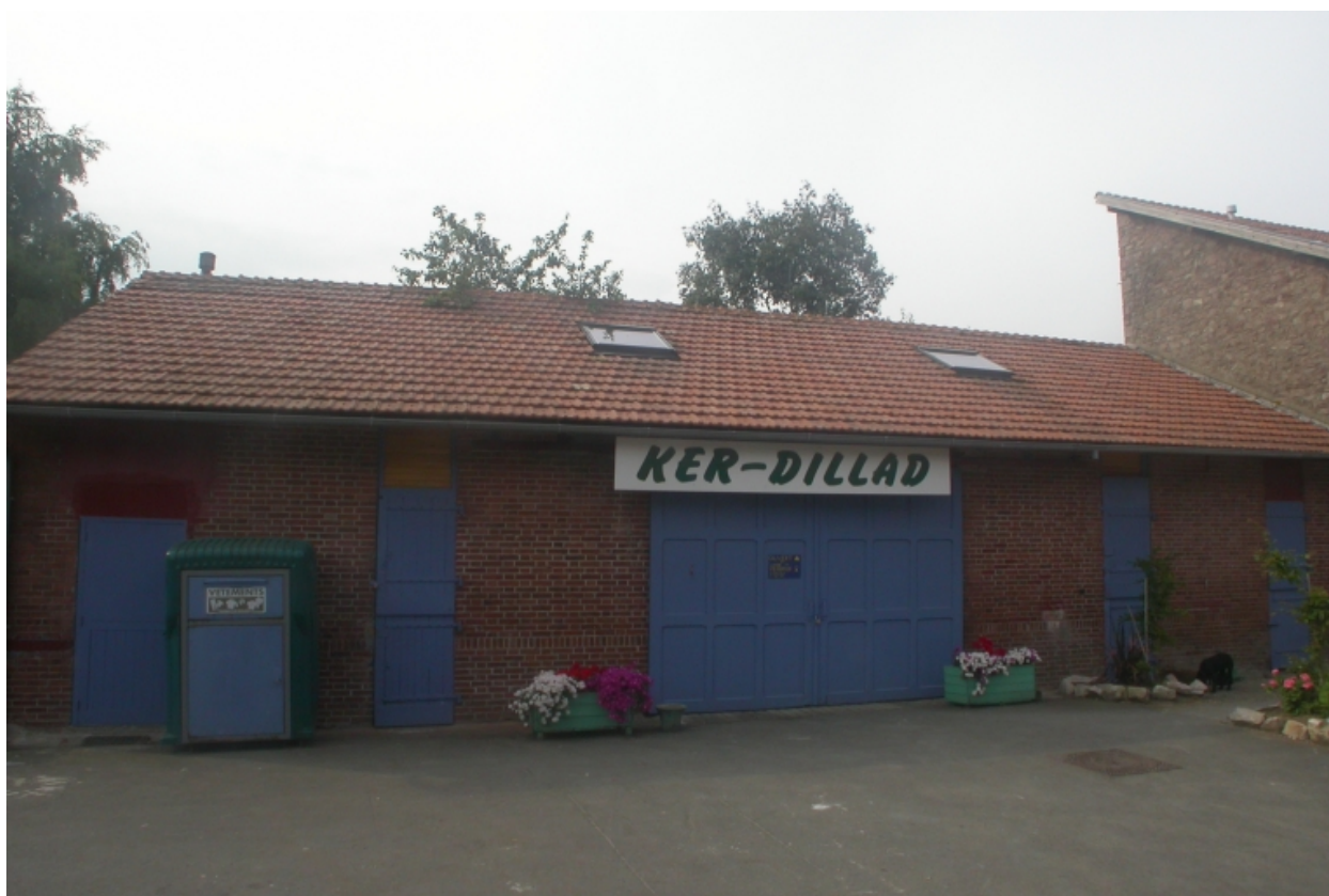
Détail du bâtiment sud.
