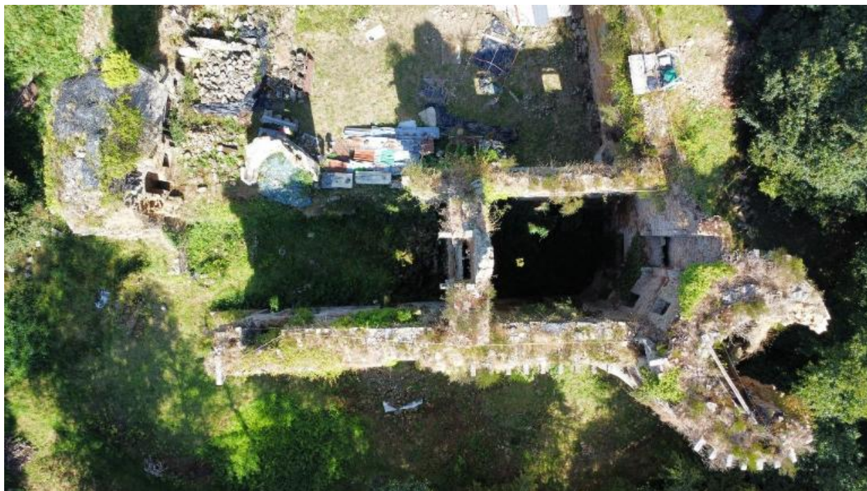
Vue aérienne verticale : corps de bâtiment sud-est du grand corps de logis et tour orientale. Une tour d'escalier desservait le grand corps de logis
