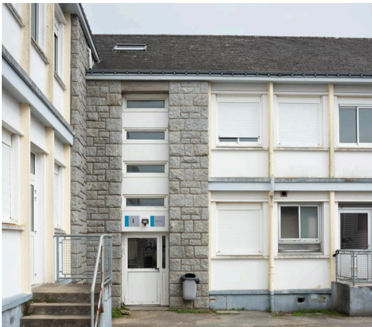
Entrée nord de l'internat. Vue prise de l'ouest. Yves Guillou et Georges Tourry, architectes, 1959.
