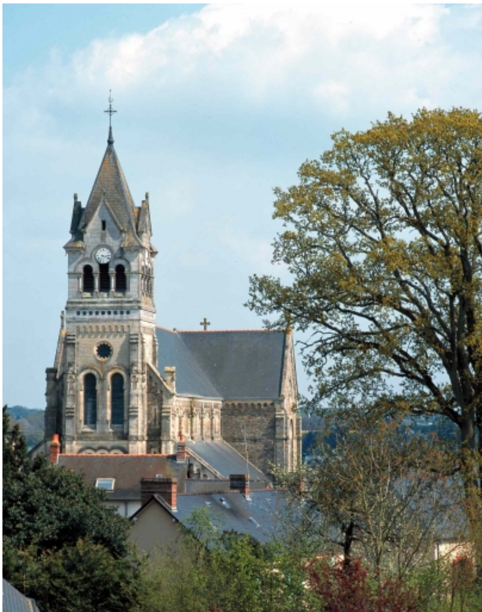
Vue de situation sud-ouest
