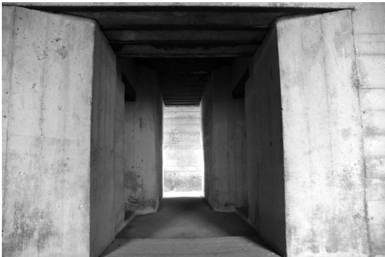
Vue de l'intérieur de l'une des quatre casemates de la batterie de Longues-sur-Mer (casemate n° 4 depuis l'est)
