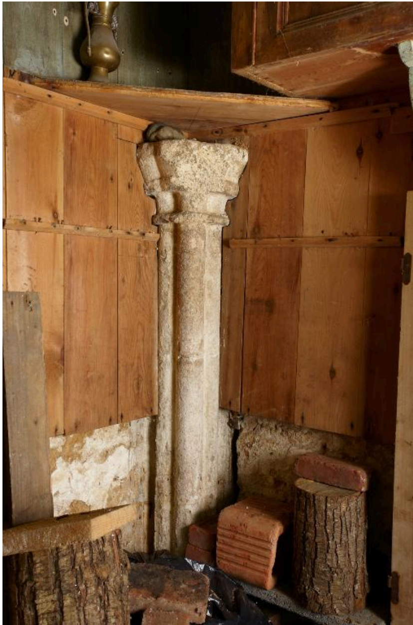
Vestige d'une pile d'angle dans le massif nord-ouest.
