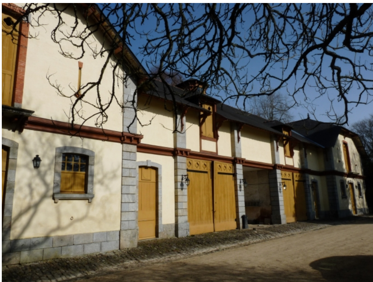
Communs, élévation est, vue sud-est
