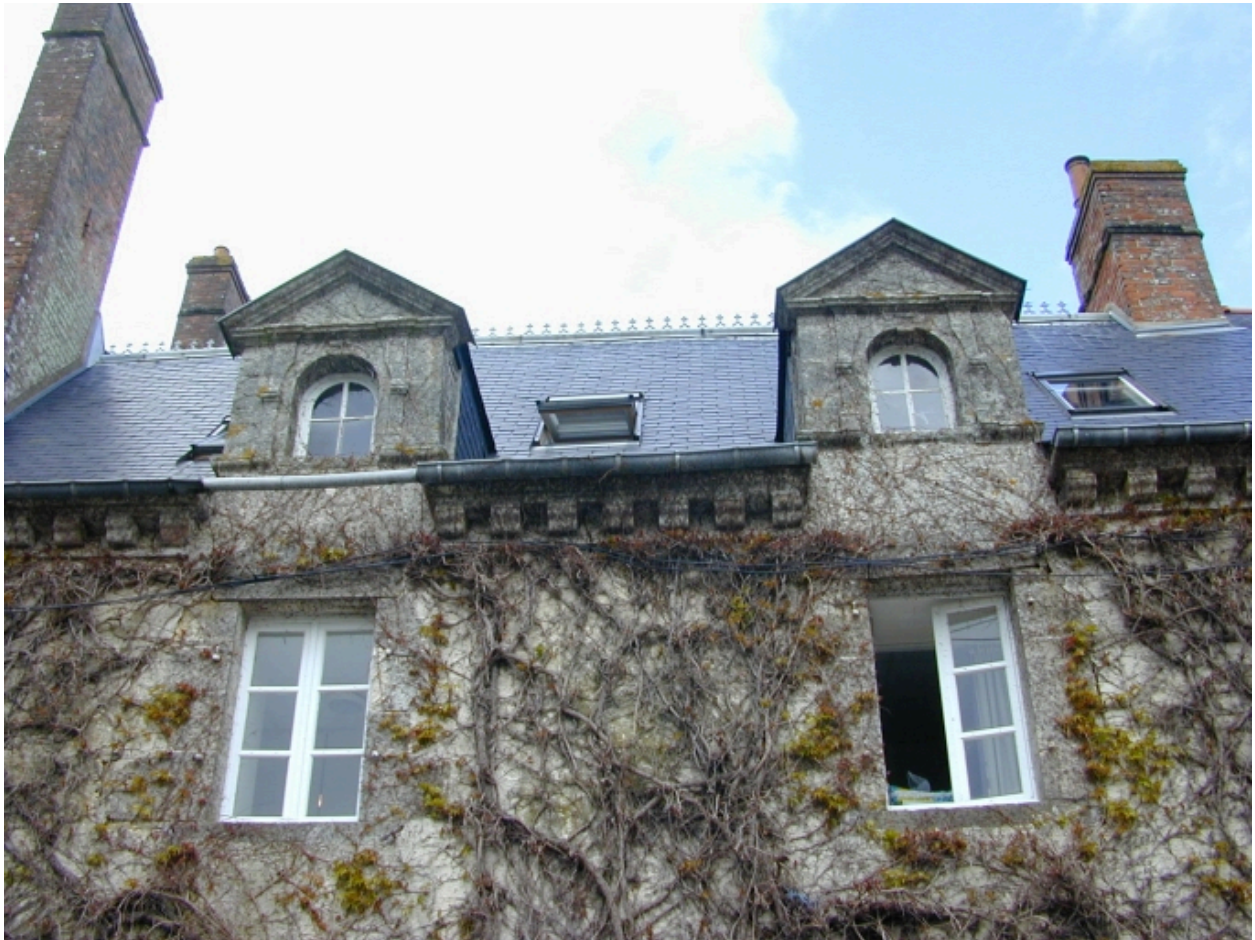
L'ancien manoir du 17e siècle : détail de la corniche et des lucarnes
