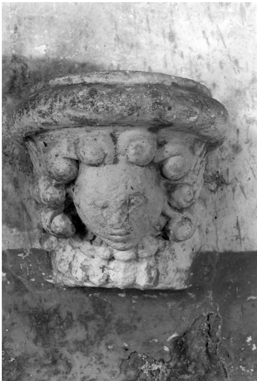
Culot du mur ouest de la nef
