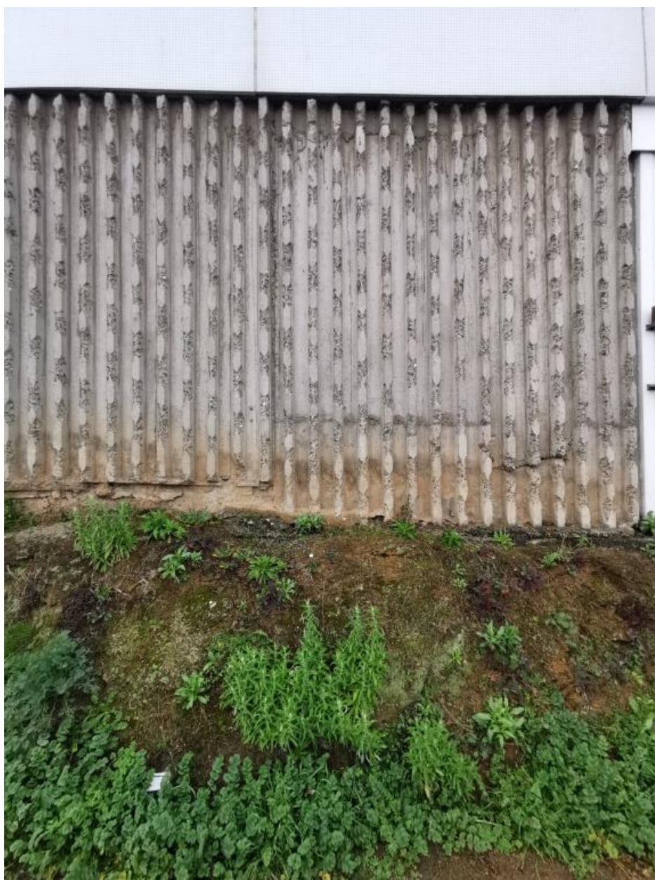
Vue de détail du socle en béton nervuré qui s'appuie sur l'enrochement préexistant
